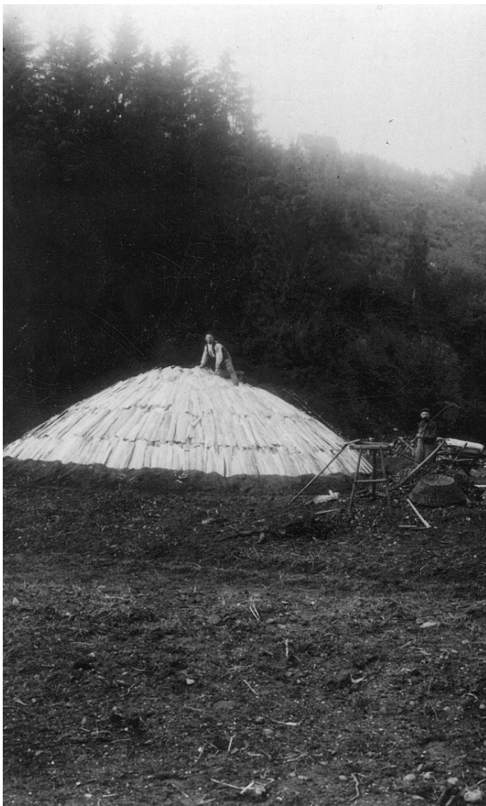
Fertiggestellter Meiler, Baiersbronn, Aue, Anfang 20. Jh
