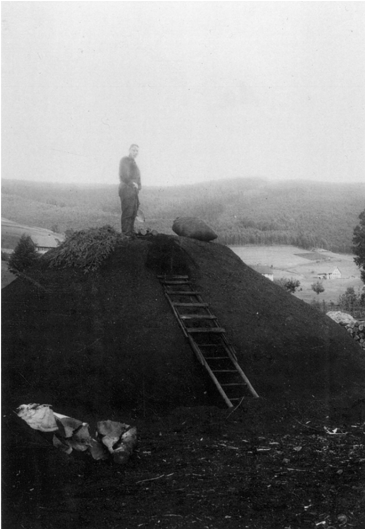
Meilerentzündung, Baiersbronn-Mitteltal, Siehdichfür, Anfang 20. Jh
