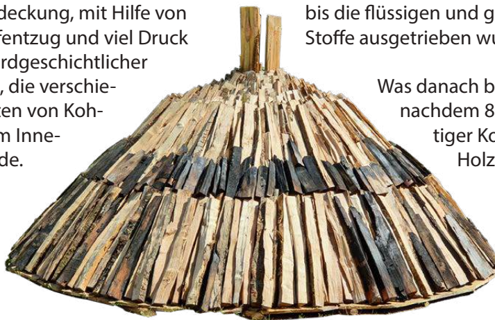
Fertiggestellter Meiler, Baiersbronn, heute
